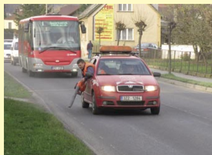
Pracovníci dodavatele opravy odstraňují nečistoty z vozovky FUKAREM!
