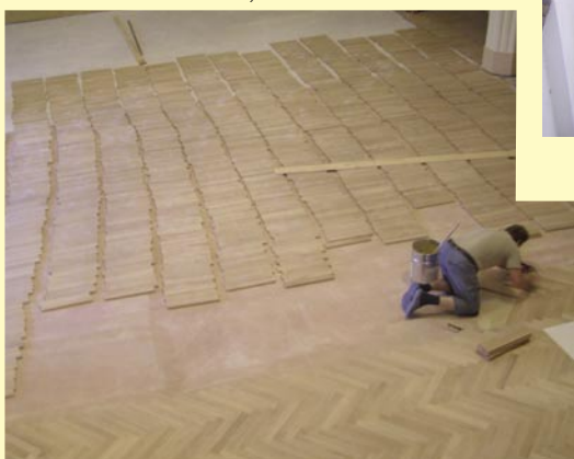
Rekonstrukce podlahy sálu, rok 2012
