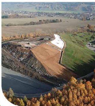
budoucnost skládky a vize 2030
